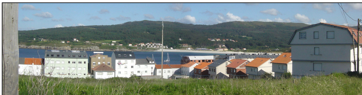
VISTA DO ÁMBITO DENDE A RÚA DA INSUA
